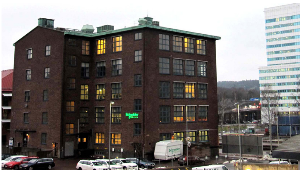
Befintlig kontorsbyggnad med Mölndalsvägen i bakgrunden.
